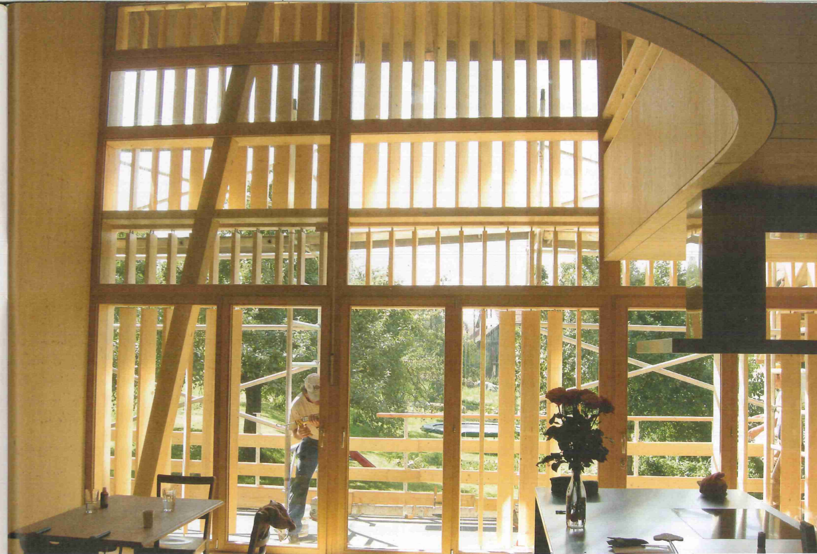
Vor die Fensterfront der Scheune wird ein einfacher Leichtbaukörper montiert. Dadurch entsteht ein urchiges und zugleich helles Ambiente.
