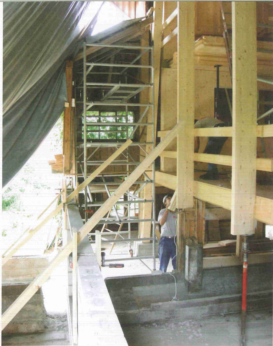
Der Heubau dieser Scheune eignete sich gut für den Einbau einer «Kiste». Die Konstruktion für den Wohnraum wird vom alten Boden getragen.
