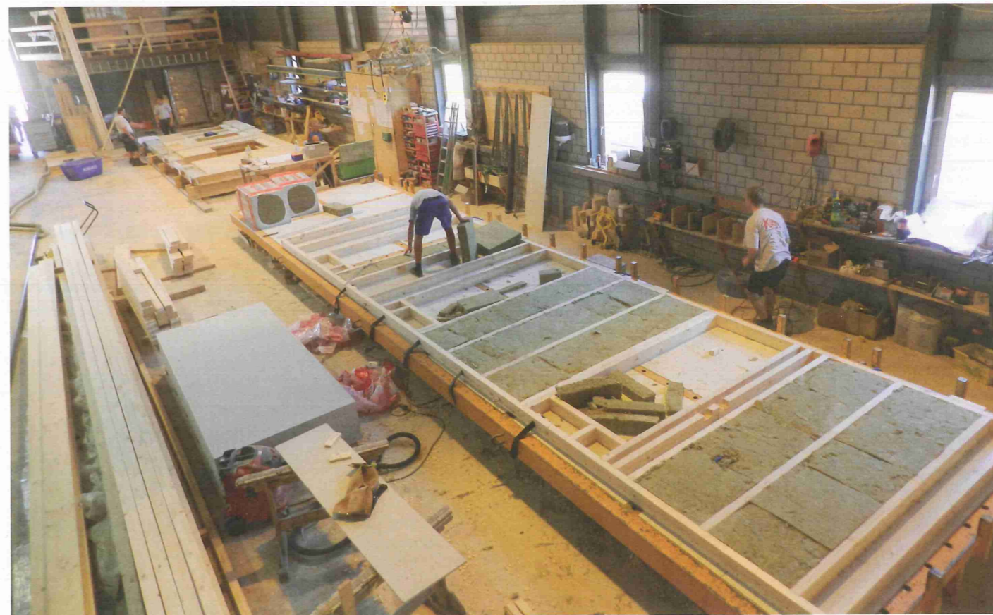
Bei der Kälin Holzbau AG in Hinwil werden die Gebäudeteile weitgehend vorgefertigt. Es kommt auch vor, dass sie an der Baustelle zusammgebaut werden.
